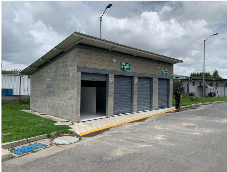
Ilustración 12. Centro de acopio de residuos convencionales CGAC
